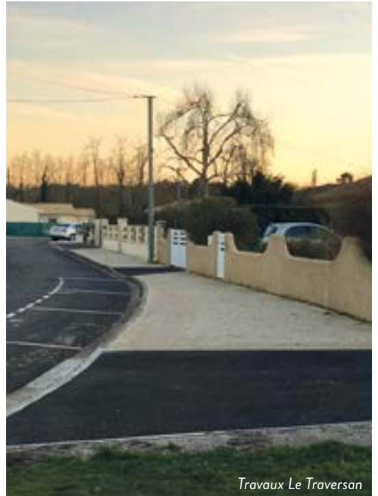
Travaux parking mairie
